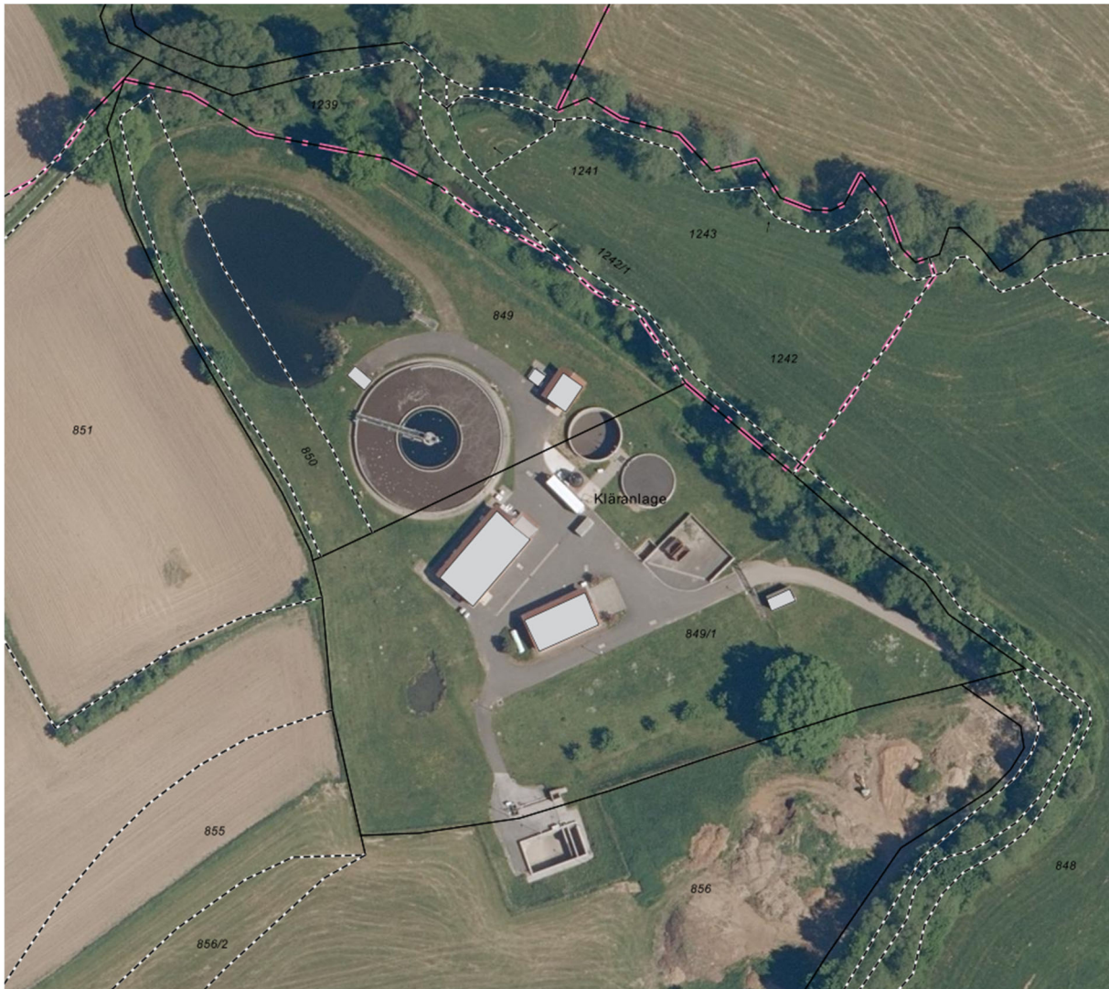
Luftbild der Kläranlage
